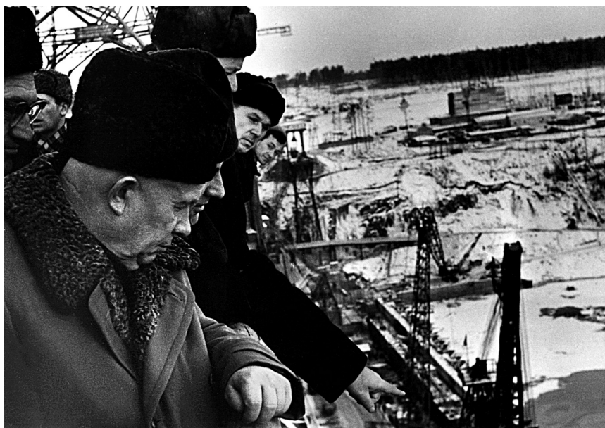
На высотной плотине Братской ГЭС.
