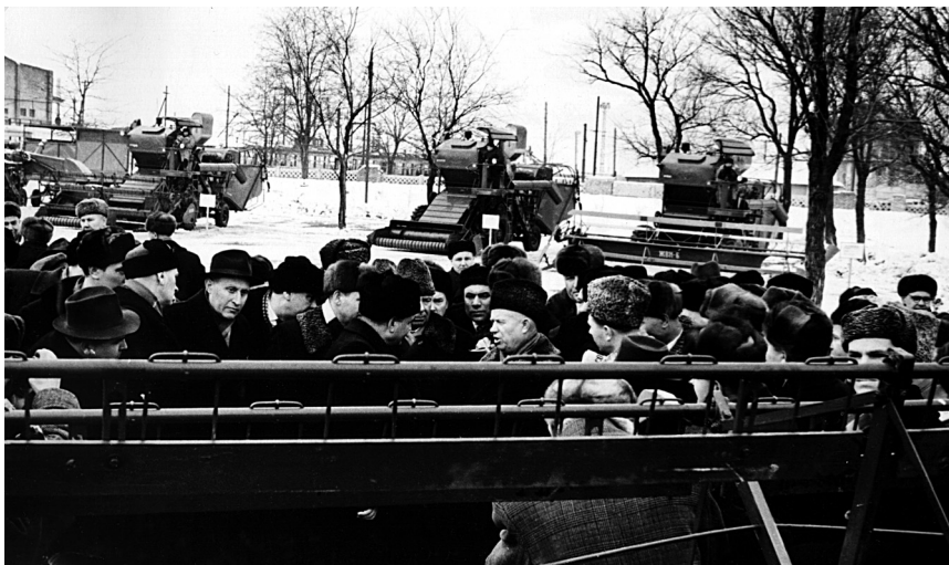
На технической площадке МТС.
