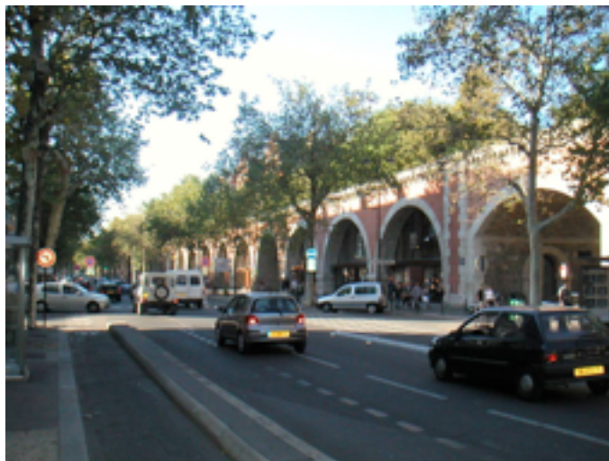
Figure 1.2: Viaduc des Arts
