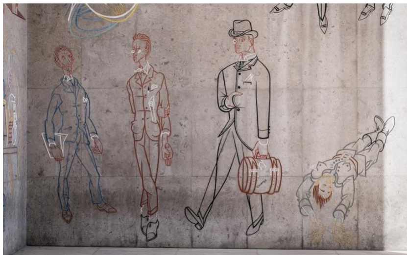
Fig. 2. Arq. Porfírio Pardal Monteiro e José de Almada Negreiros, Fachada da Faculdade de Letras, Lisboa.
